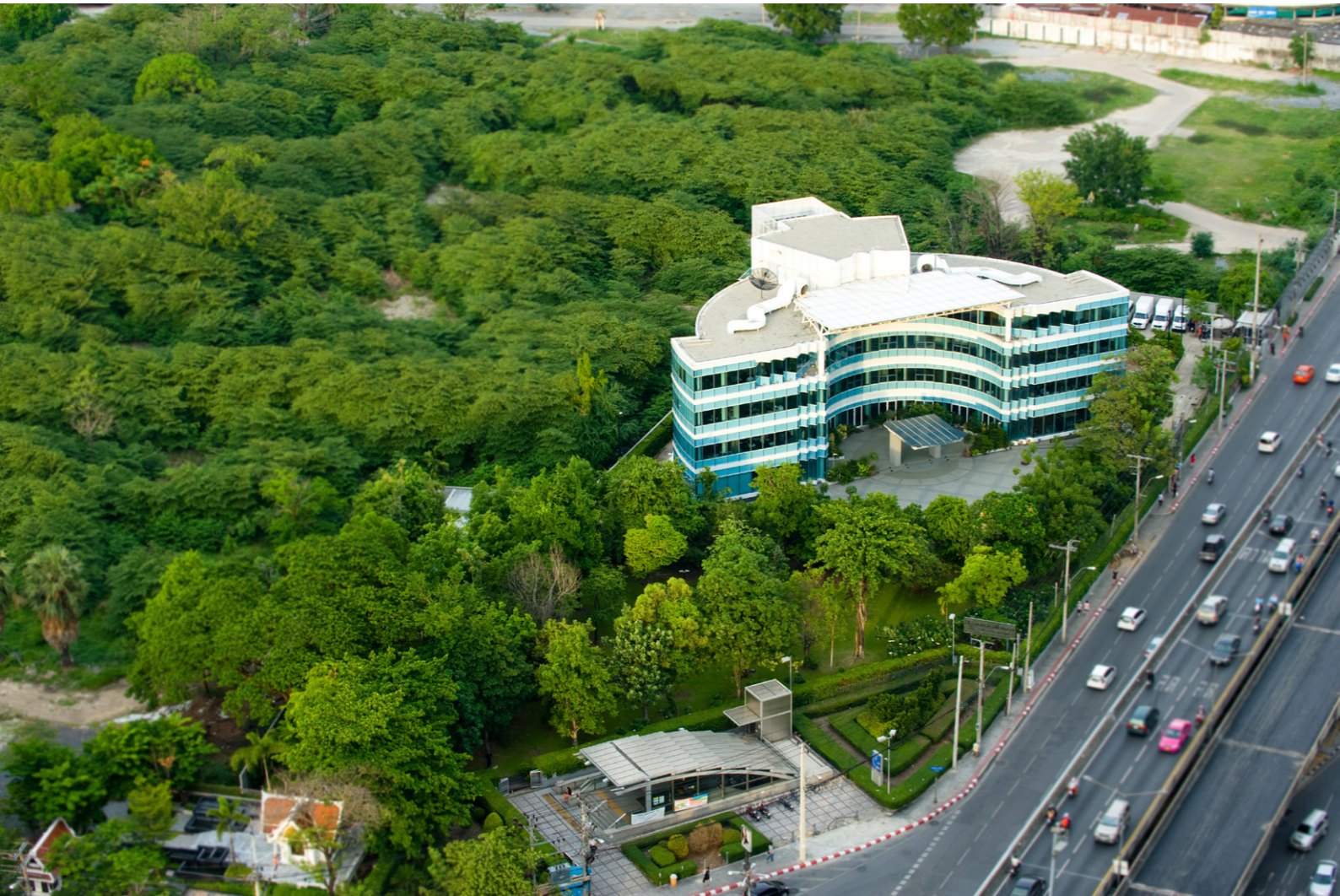
ความพิถีพิถันในการก่อสร้างและบริหารจัดการด้านสิ่งแวดล้อม และพลังงานของสำนักงานแห่งนี้ สอดคล้องกับหลักการพัฒนาของมูลนิธิแม่ฟ้าหลวง ในพระบรมราชูปถัมภ์ให้ “คนกับป่าอยู่ร่วมกันอย่างพึ่งพาอาศัย”
