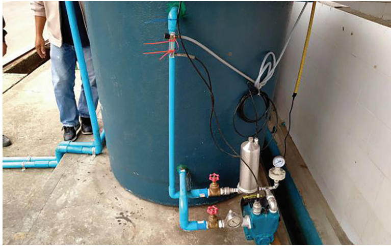
รูปที่ 5 ติดตั้งเครื่องสร้างฟองอากาศแบบละเอียดในถังแยกไขมัน
