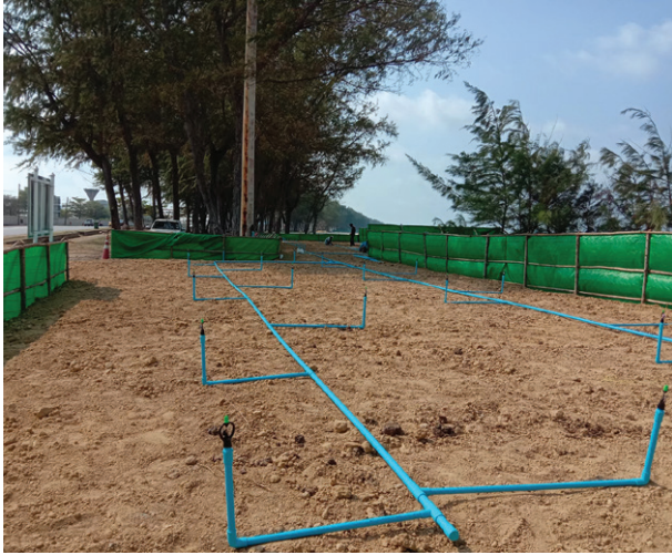
ค) การติดตั้งระบบน้ำ
